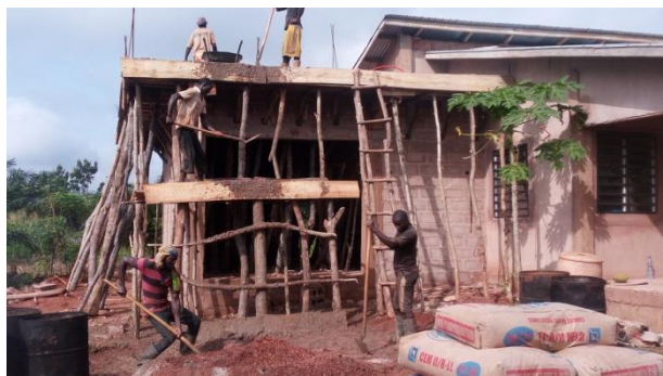
Construction du château d'eau à Ouegbo
