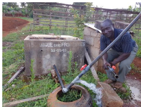
Photo du puits
